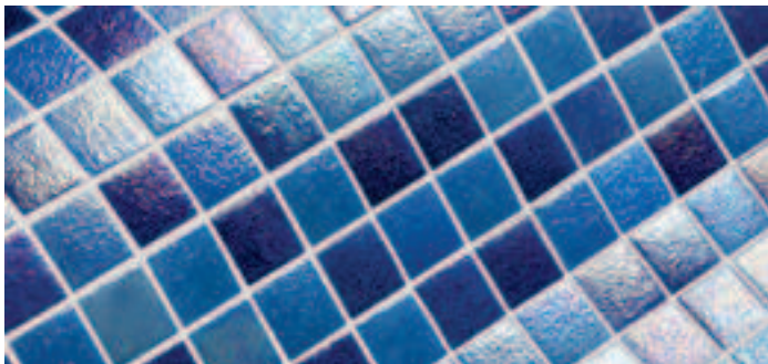
Junta blanca // White grouting
